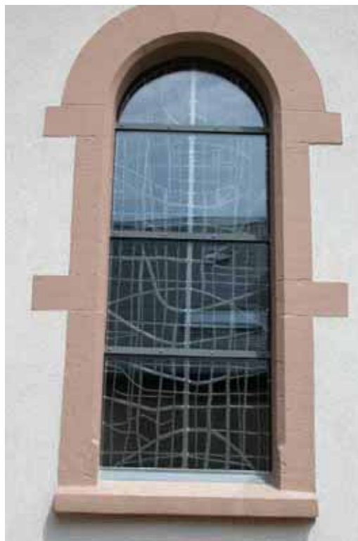
Après restauration. Église Landscheid (Luxembourg).
