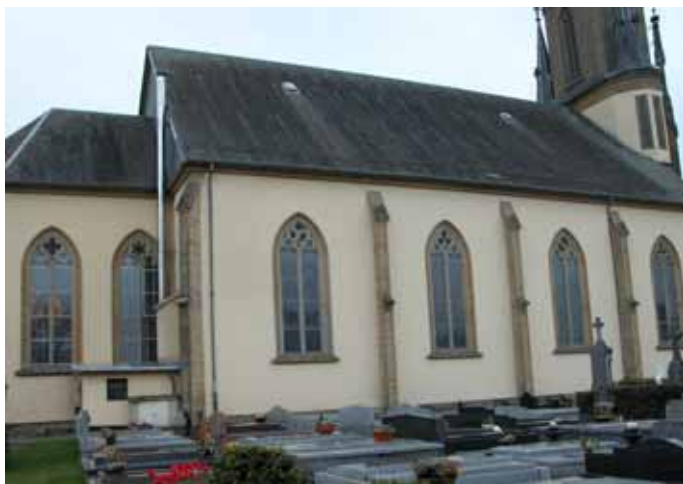
Après restauration. Église Niederanven (Luxembourg).
